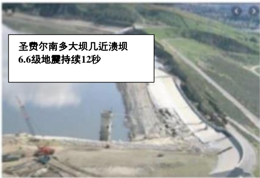
图 6 a. 2008 年老挝桑片-桑南内大坝溃坝；这张照片拍摄后不久，大坝决堤，5 亿立方米的水倾泻 100 公里，淹没了 6 个村庄。虽然没有发生地震，但此坝建在典型的易渗、不坚实的热带土壤上，且建造质量不过关，因而无法经受住蓄水的考验。b. 加州圣费尔南多大坝在持续时间很短的 6.6 级地震中几近溃坝。若震动再持续几秒，大坝就会溃决，造成大量人员死亡。c. 蔡、王等人对 2008 年汶川地震中某尾矿坝的分析表明，该尾矿坝在 8 级地震中发生溃坝事故。d. 达瑞矿场尾矿坝在强震中的可能表现，地震可能发生在临近矿场的大苏门答腊断层带。
