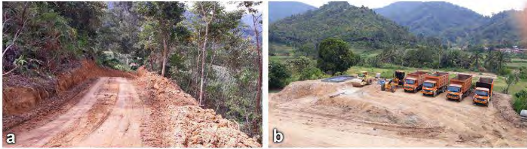
Gambar 2.13 (a) Jalan Tambang Yang Sedang Dikerjakan (b) Alat Berat Pendukung Pembuatan Jalan Tambang
