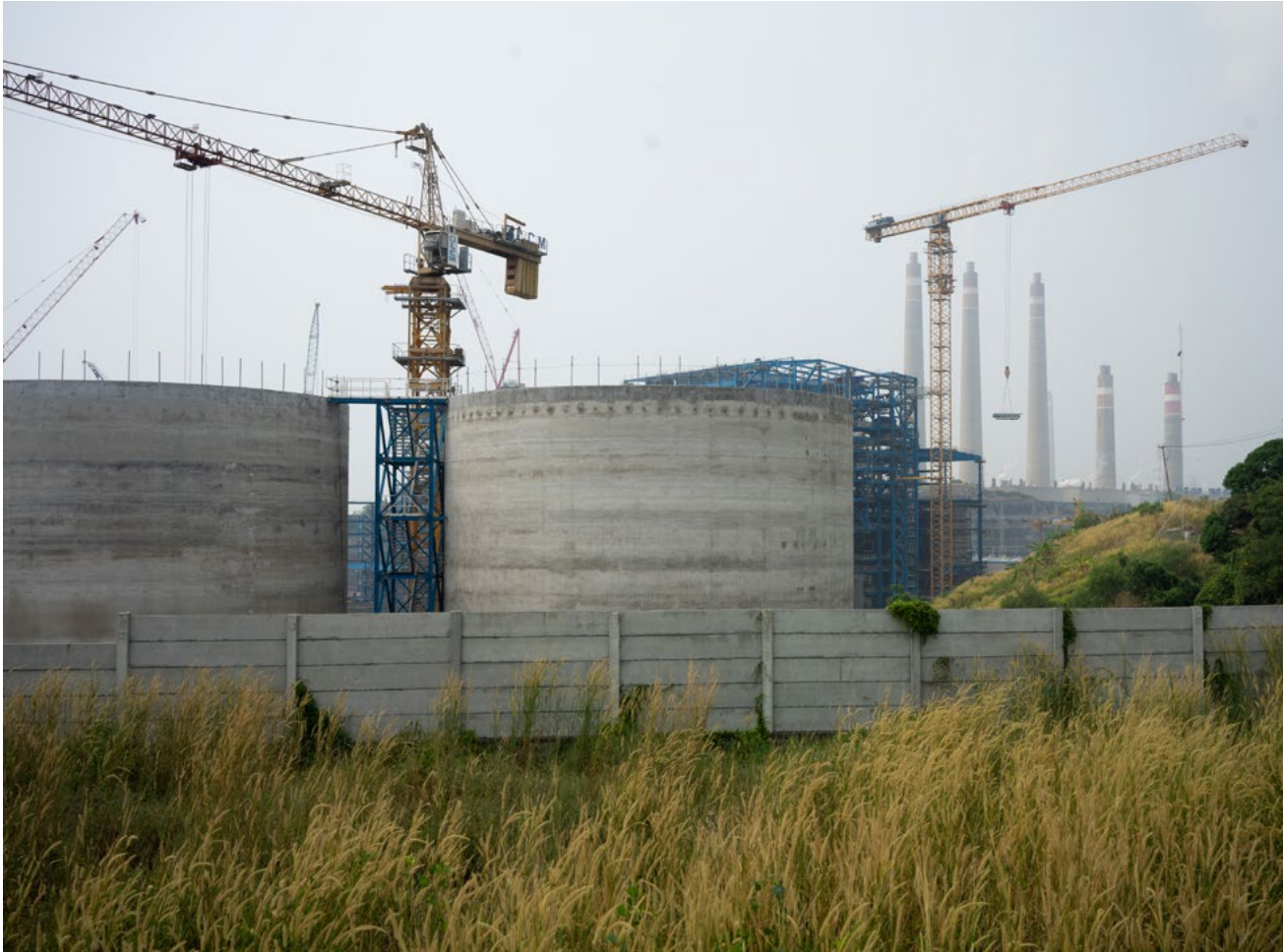
Pembangunan PLTU Jawa 9 & 10 saat ini akan membuat generasi baru terpapar dampak-dampak polusi batubara.
